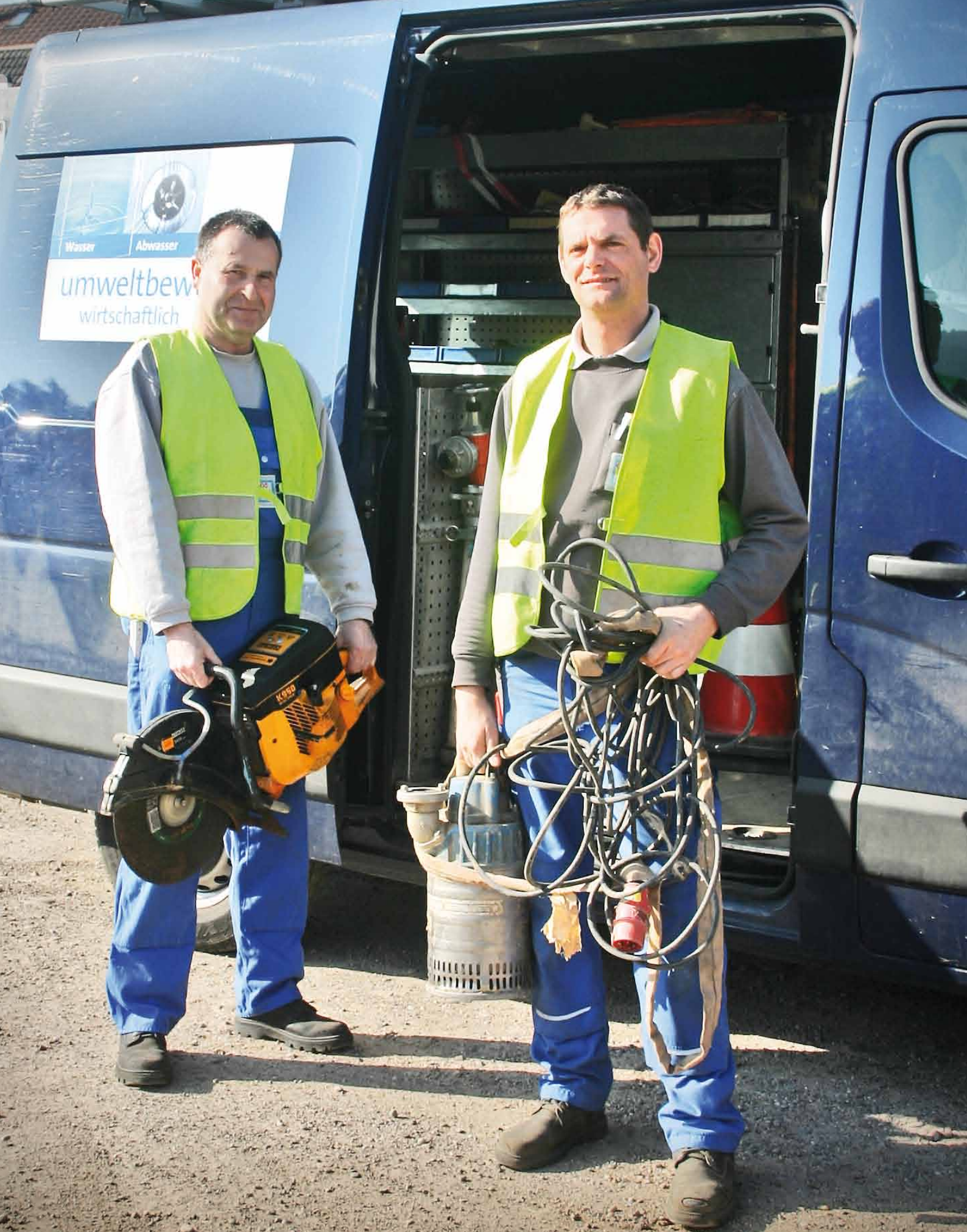
Martin Litterst und Alfred „Freddy“ Hahn sind bereit für den nächsten Notfall. Der schnelle Einsatz bei Wasserrohrbrüchen, die zügigen Instandsetzungen und gegebenenfalls unkomplizierte aber praktikable Provisorien wie in diesem Fall gehören zu den Dienstleistungen der Stadtwerke Gengenbach.
