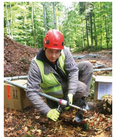
Der Monteur richtet auf dem Boden den Ausleger vor und installiert die Anemometer (Windmesser), die Luftströmung, Windgeschwindigkeit und weitere Daten erfassen.
