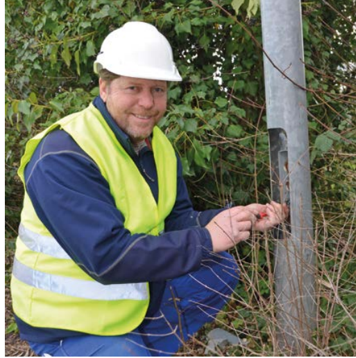
Links: Tom Gißler von den Stadtwerken Gengenbach mit einer der neuen LED-Leuchten.
