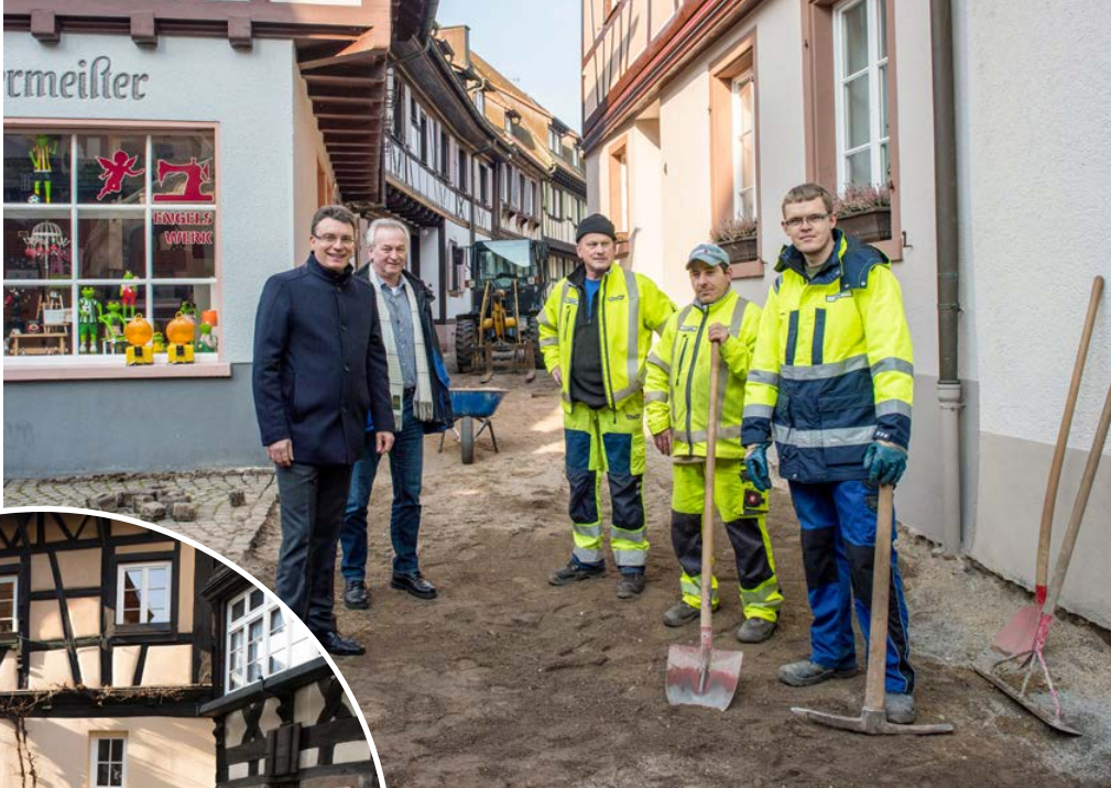
Begutachten die Baustelle in der Engelgasse, v. l. Bürgermeister Thorsten Erny, Meinrad Huber, Leiter Technische Dienste Gas/Wasser/Wärme, Helmut Springmann, Martin Schmieder und Eugen Fink vom ausführenden Tiefbauunternehmen.
